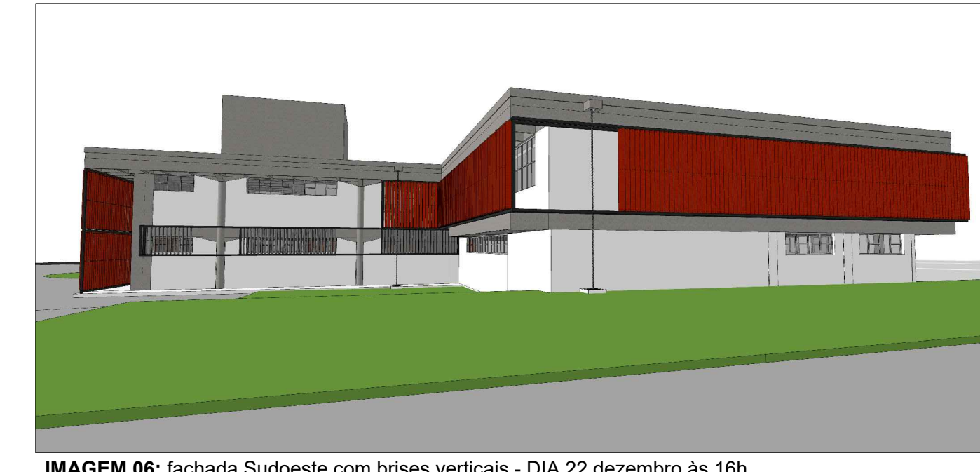
IMAGEM 06: fachada Sudoeste com brises verticais - DIA 22 dezembro às 16h - 1ª PAV: brise vertical em painel perfurado em alumínio extrudado 300mm de largura, referência aeroscreen hunter douglas - cor Naranja escuro 4557. - TERREO: brise vertical em painel perfurado em alumínio extrudado 300mm de largura, referência aeroscreen hunter douglas - cor Alumínio médio 7257
