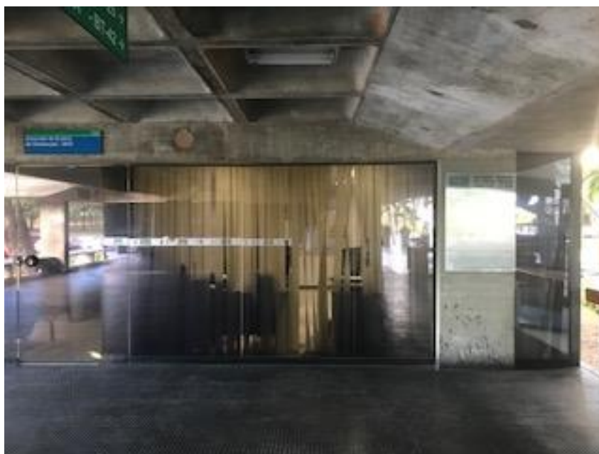
Figura 2 – Área de intervenção Guarita 01 – Próximo ao DEG.
