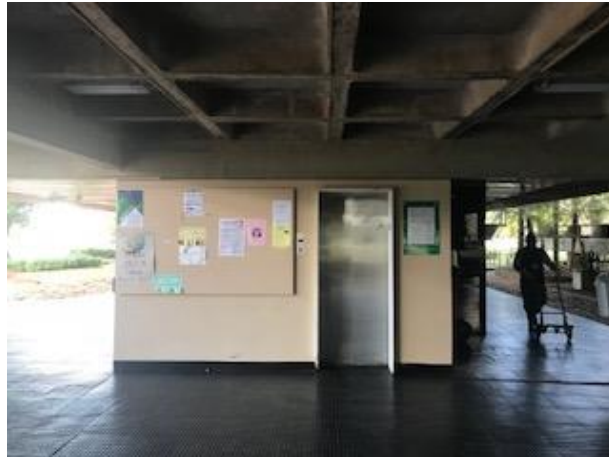
Figura 3 – Área de intervenção Guarita 02 – Próximo ao elevador social.
