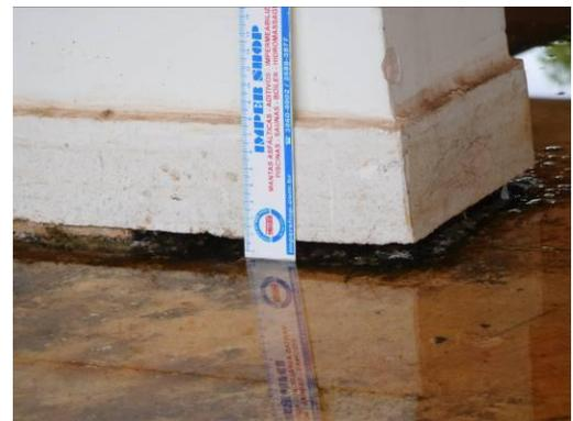
Detalhe de fissura na base das alvenarias e da deformação do piso
