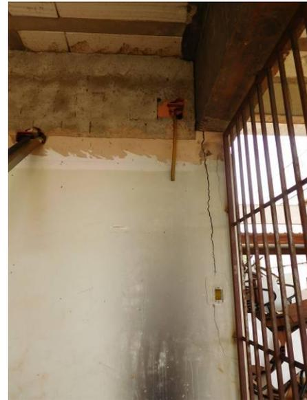
Detalhe das fissuras na alvenaria sobre cinta C10
