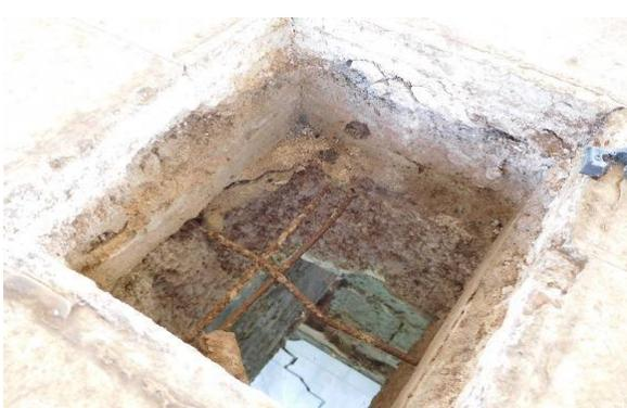
Another photograph looking down into a square hole in a precast concrete slab, showing the reinforcement bars in an incorrect position, similar to the previous image.             | Segundo pavimento<br>Ponto 90<br><br>1-Detalhe de posição inadequada da armadura de distribuição da laje pré fabricada |
