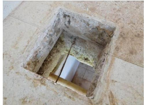
Detalhe do posicionamento das armaduras de distribuição das lajes pré-fabricadas entre o isopor de enchimento das nervuras e o capeamento de concreto
