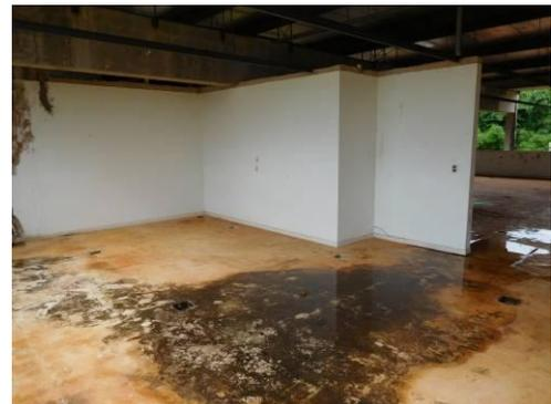
Vista geral do piso do lado direito do segundo pavimento e detalhe de bacia formada pela deformação da laje
