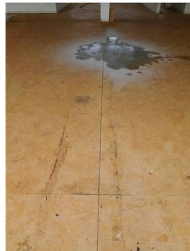
Fissuras típicas de insuficiência ou inexistência de armadura negativa no encontro de lajes
