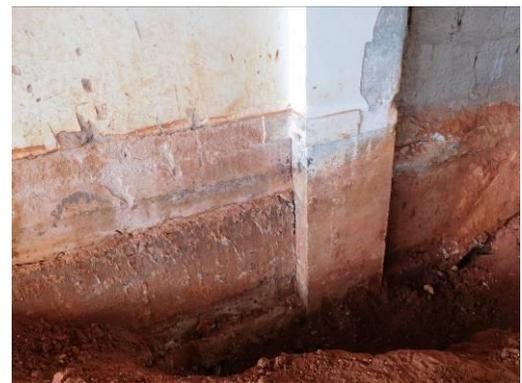
Detalhe da deformação a flexão da cinta C13 e das fissuras características na base da parede, formando efeito arco.
