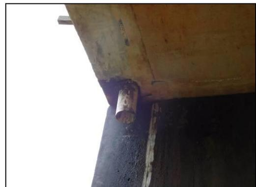
Detalhe de dano para instalação do SPDA e fixação do sistema de drenagem
