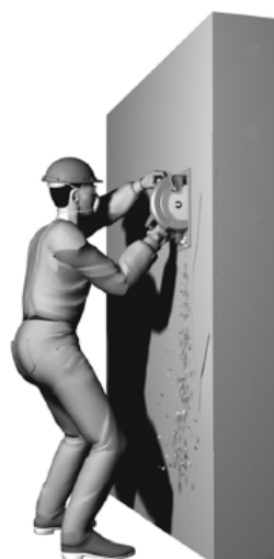
Figura 5 – Delimitação da área de reparo com disco de corte
