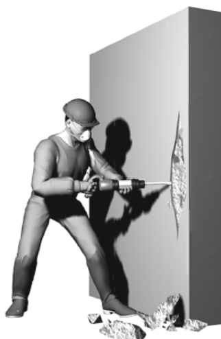
Figura 4 – Demolição superficial do concreto
