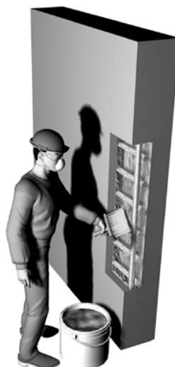
Figura 7 – Aplicação da proteção anticorrosiva nas armaduras
