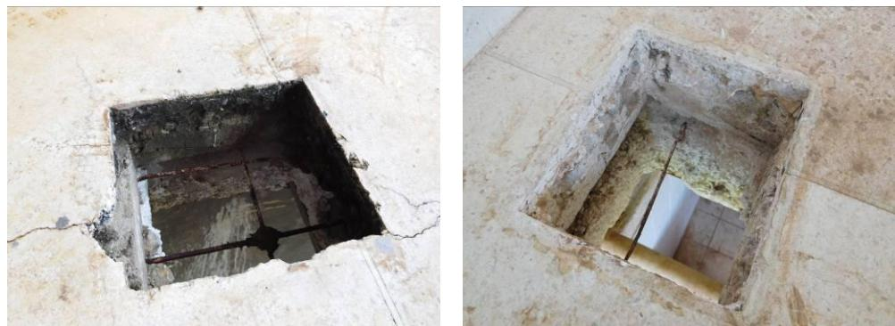
Detalhe do posicionamento das armaduras de distribuição das lajes pré-fabricadas entre o isopor de enchimento das nervuras e o capeamento de concreto
