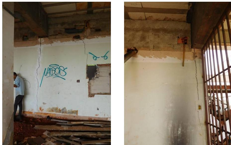
Detalhe das fissuras na alvenaria sobre cinta C10
