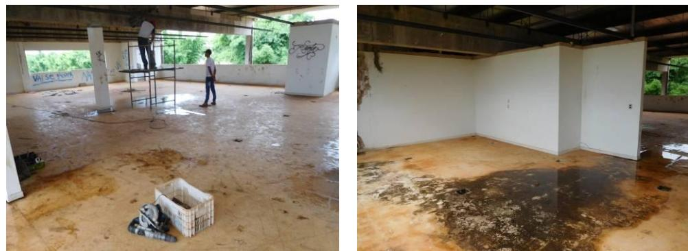
Vista geral do piso do lado direito do segundo pavimento e detalhe de bacia formada pela deformação da laje
