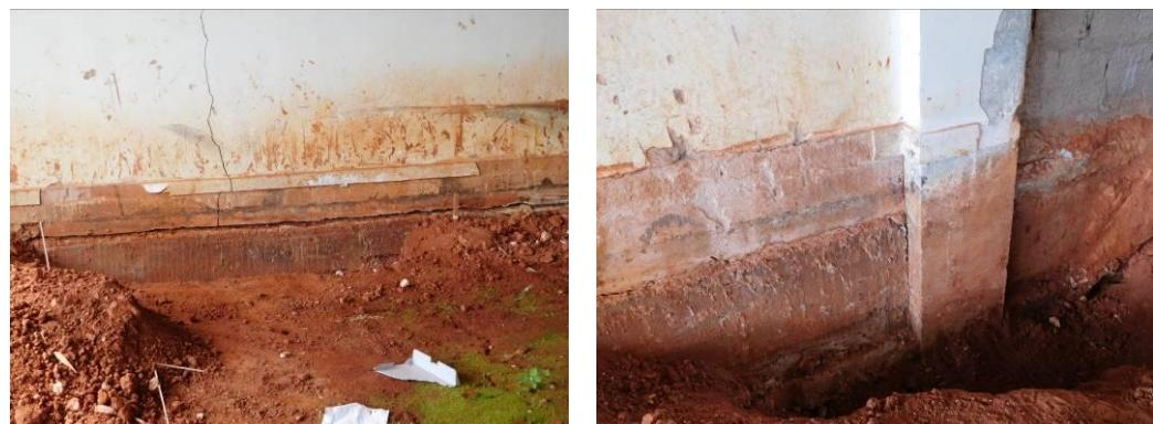
Detalhe da deformação a flexão da cinta C13 e das fissuras características na base da parede, formando efeito arco.
