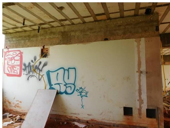
Destacamento da alvenaria sobre a cinta C14
