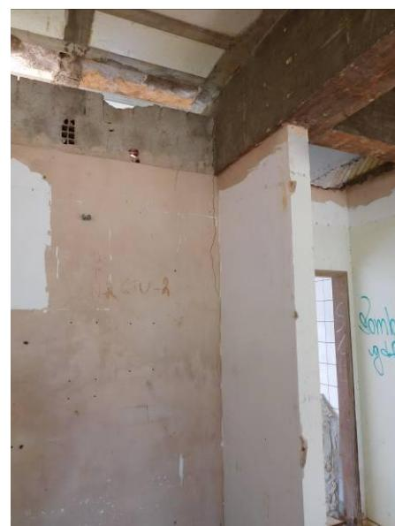
Detalhe de fissura de destacamento da alvenaria
