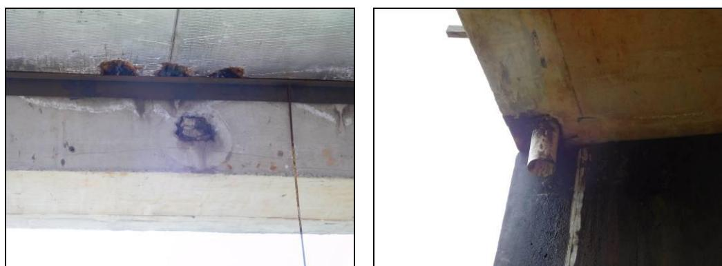
Detalhe de dano para instalação do SPDA e fixação do sistema de drenagem
