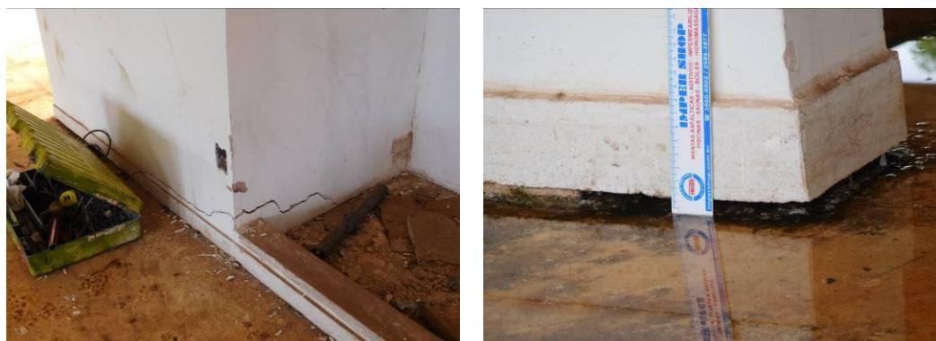
Detalhe de fissura na base das alvenarias e da deformação do piso
