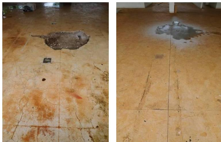
Fissuras típicas de insuficiência ou inexistência de armadura negativa no encontro de lajes
