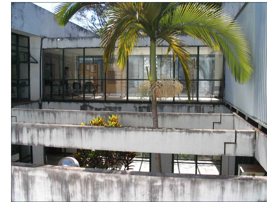
VISTA DA FACHADA EXTERNA
