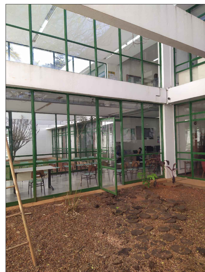
VISTA DA FACHADA EXTERNA
