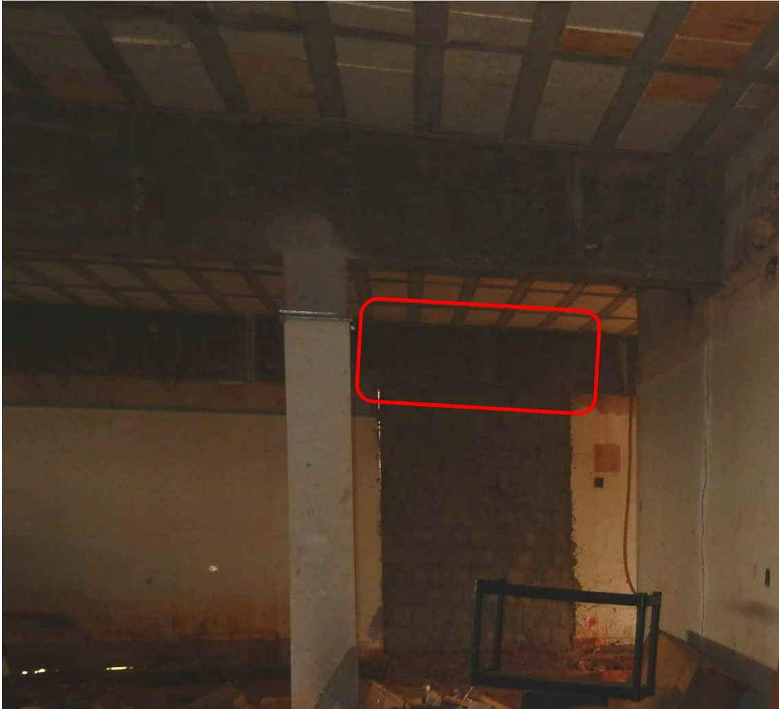
Figura 08 – Lado interno da edificação, no destaque deveria ter a continuidade da marquise.
