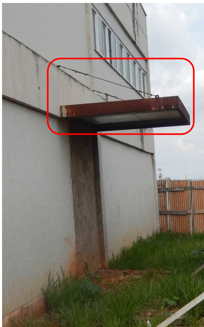
Figura 07 – Lado externo da edificação, marquise metálica com tirantes em cabo de aço.
