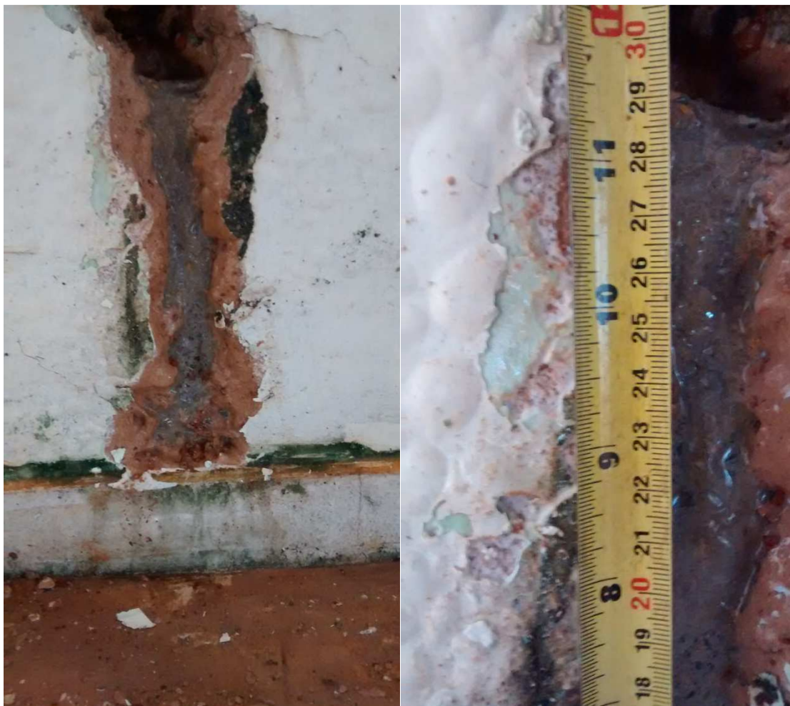
Figura 12 – Sondagem em parede (lado interno) do 1º pavimento da Unidade de Administração e Serviços – UAS, fachada leste.
