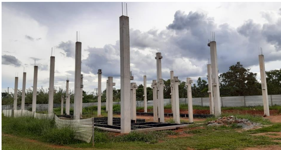
Foto 8 – Execução de serviços na obra de conclusão do LGC.
