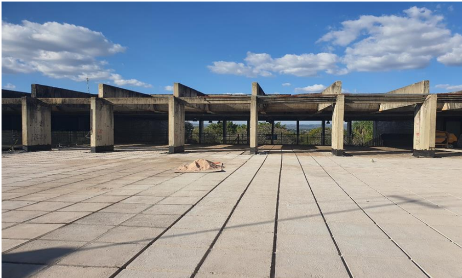
Foto 5 – Obra de restauração estrutural do mezanino, localizado no acesso norte do Instituto Central de Ciências
