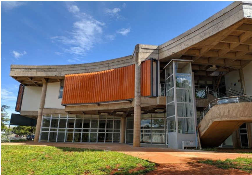
Foto 6 – Obra de conclusão da 2ª etapa do Centro de Vivência bloco -A
