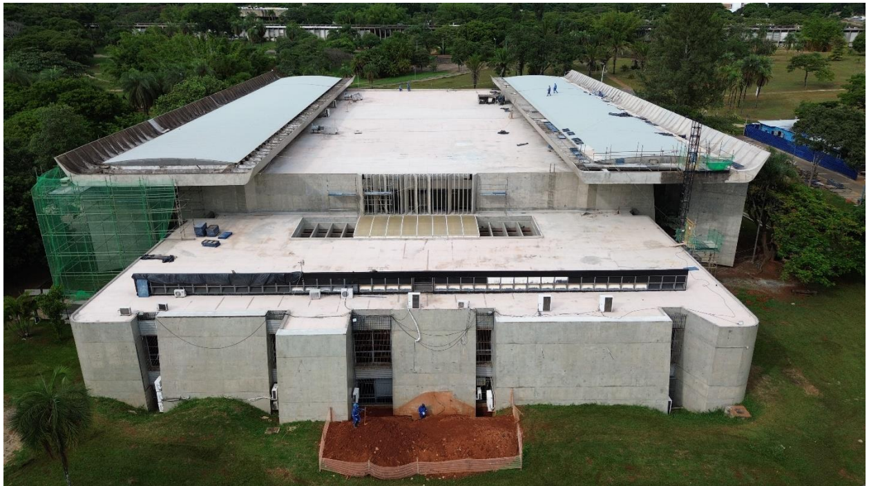
Foto 13 – BCE (recuperação estrutural). Fonte: Secretaria de Infraestrutura.
