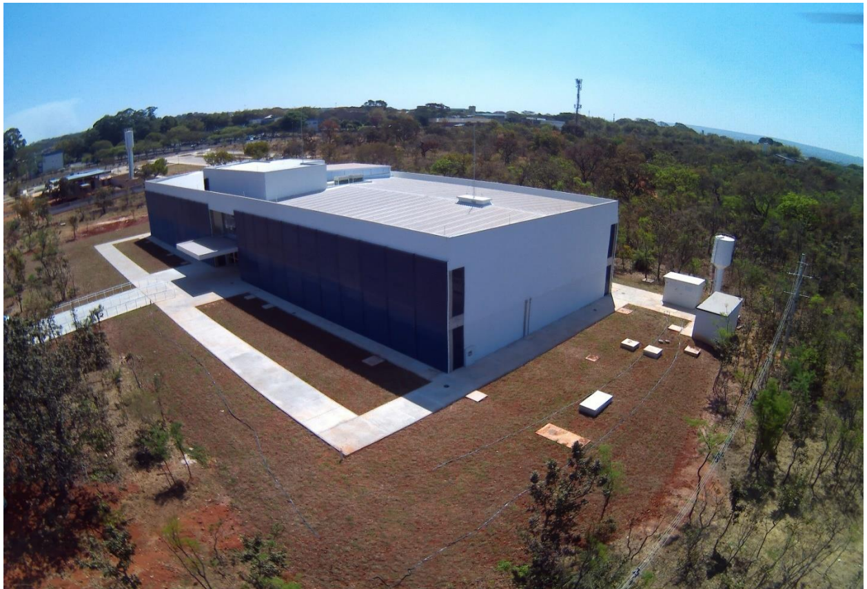
Foto 7 – C-Biotech. Fonte: Secretaria de Infraestrutura.
