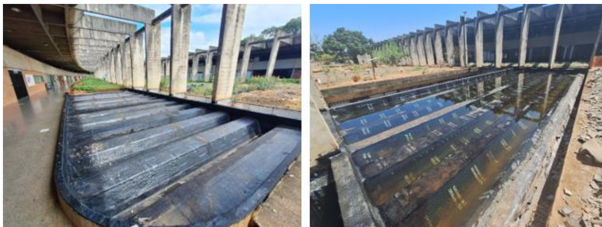
Foto 28 – Impermeabilização nos módulos. Fonte: DIMAP
