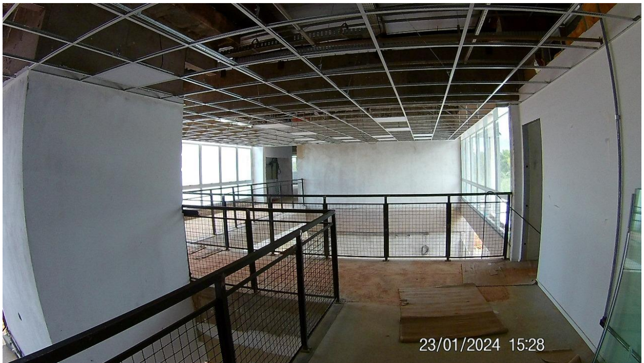
Foto 15 – Perspectiva interna da obra do LGC. Fonte: Secretaria de Infraestrutura.
