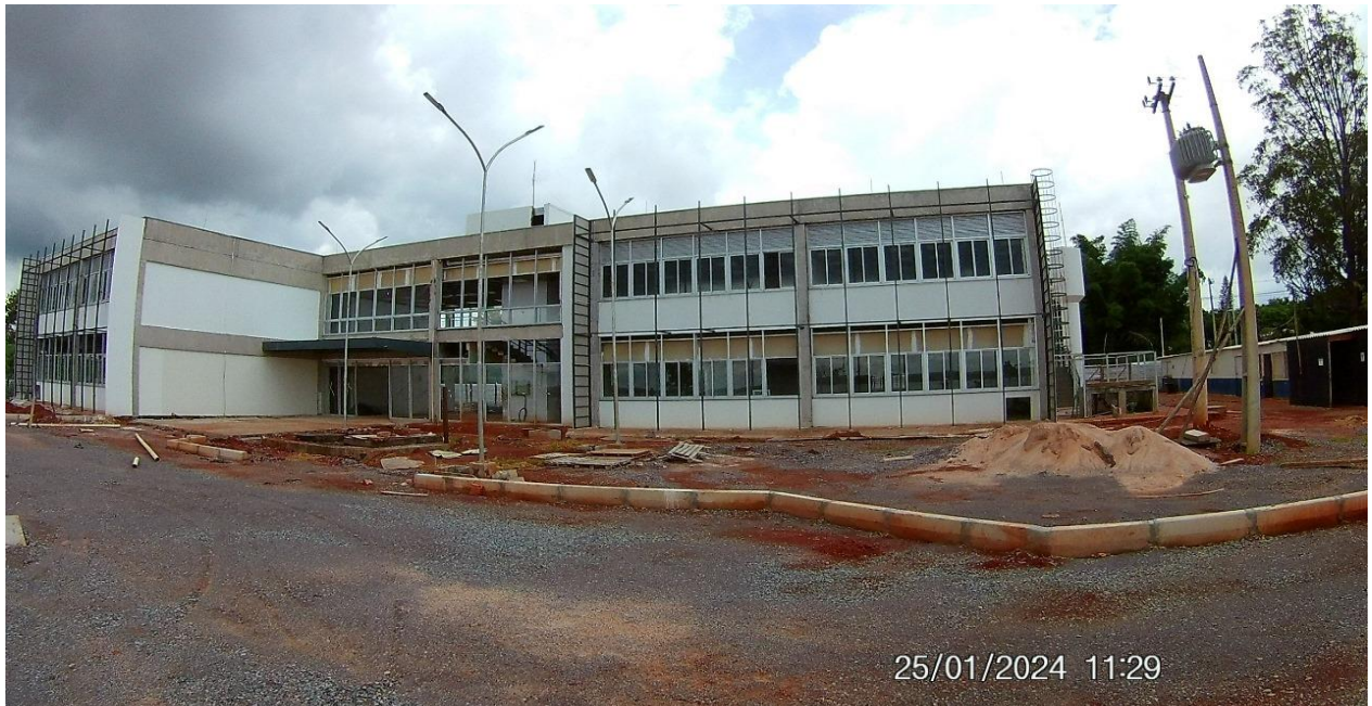
Foto 14 – Perspectiva externa da obra da UAS/FUBRA. Fonte: Secretaria de Infraestrutura.
