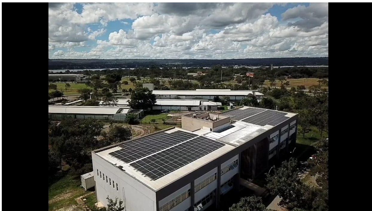
Foto 20 – STI – Usina Fotovoltaica. Fonte: Secretaria de Infraestrutura.
