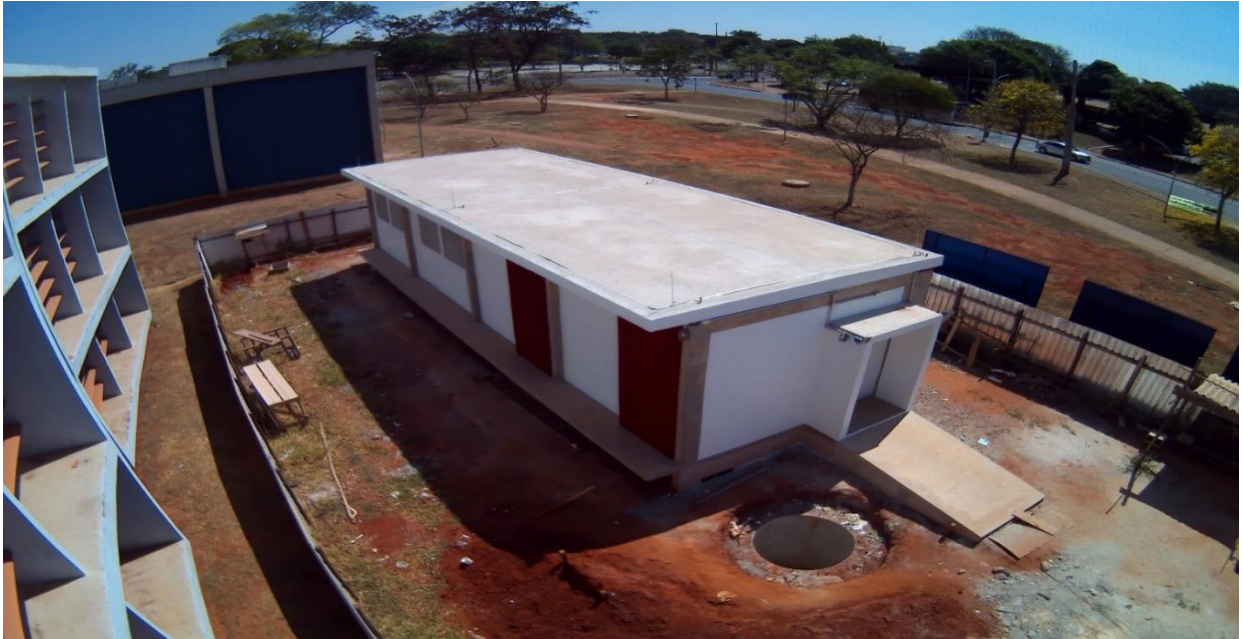
Foto 21 – Cabine de Medição. Fonte: Secretaria de Infraestrutura.
