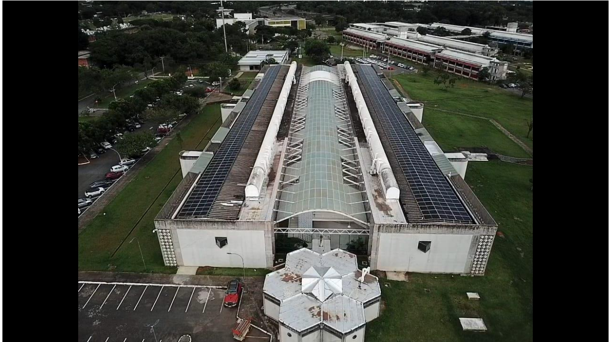
Foto 18 – IQ – Usina Fotovoltaica. Fonte: Secretaria de Infraestrutura.
