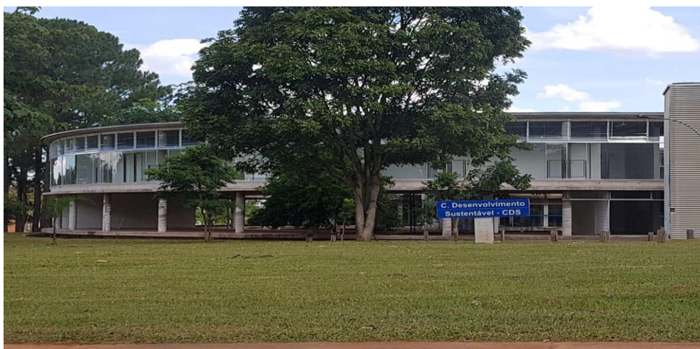
Foto 7 – CDS (conclusão do primeiro pavimento do Bloco B)
