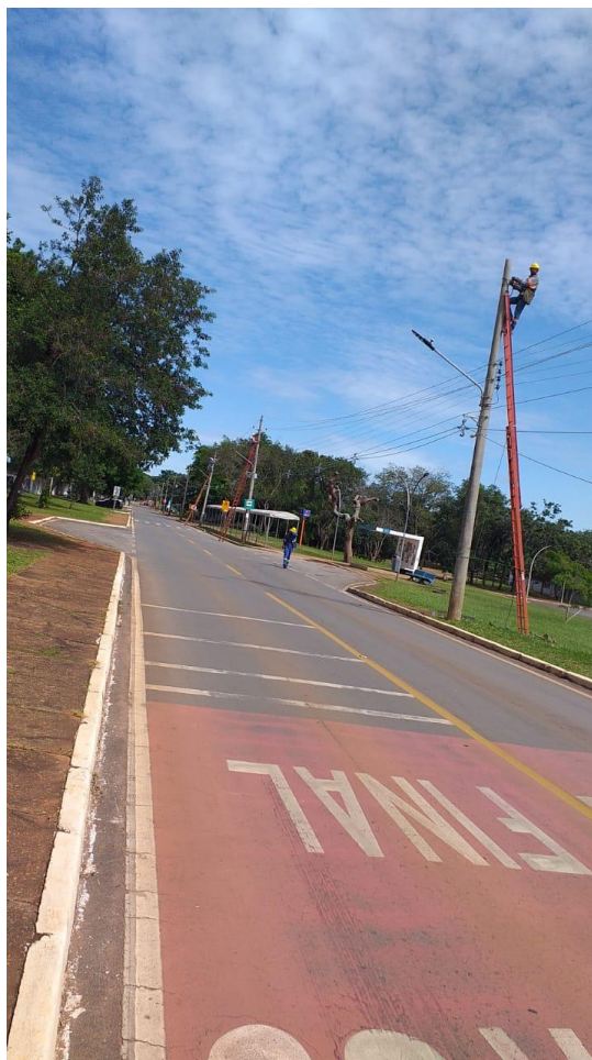
Figura 6- Ação de manutenção na rede de distribuição elétrica em média tensão no campus Darcy Ribeiro
