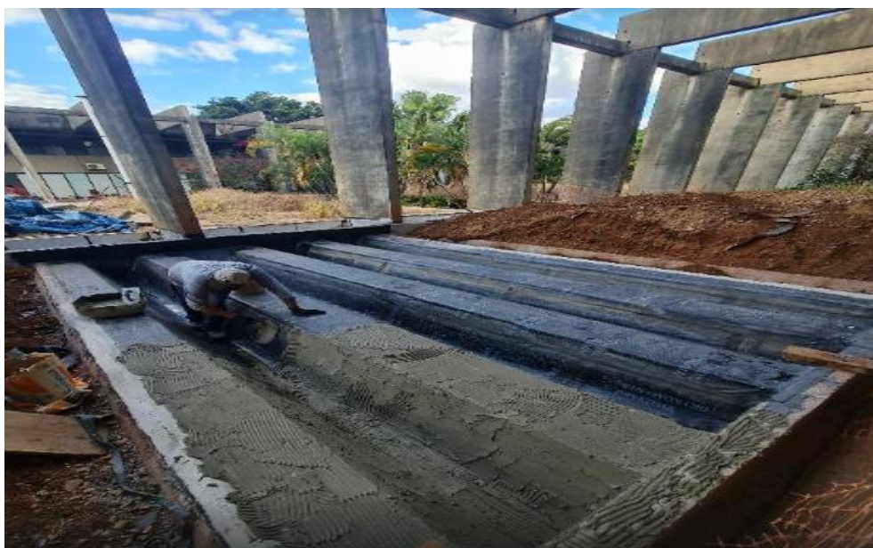
Figura 12 -Serviço de impermeabilização realizado no ICC
