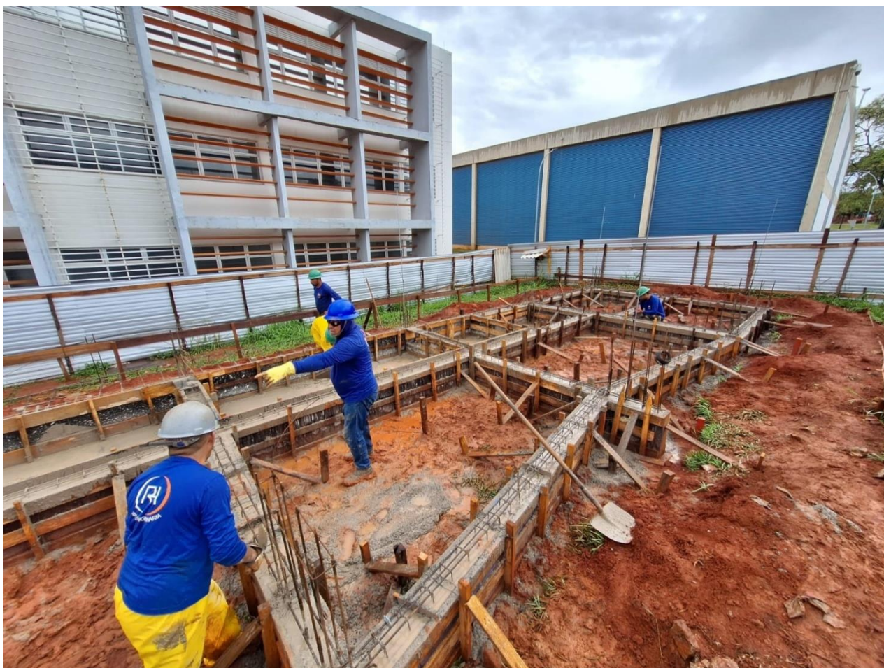
Foto 22 – Execução das vigas baldrame da obra da Cabine de Medição
